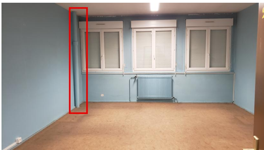
Conduite verticale en amiante
